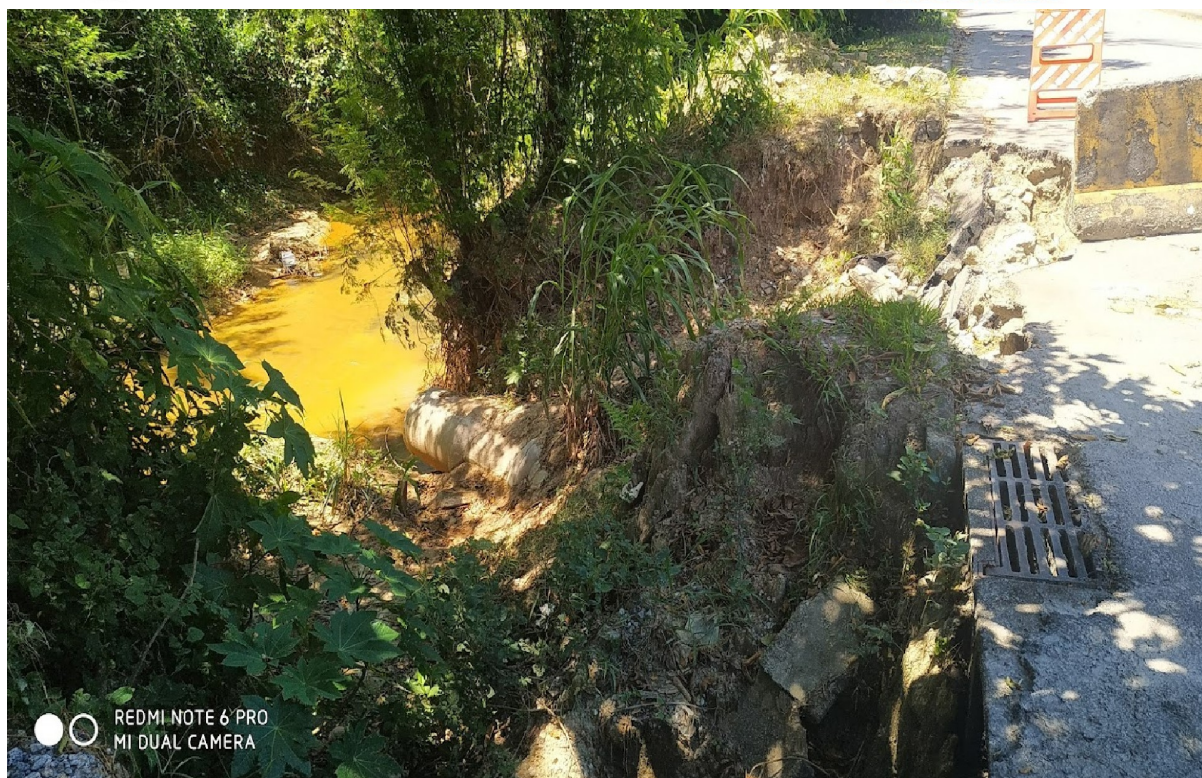
EROSÃO DAS MARGENS DO RIO INDAIAÇU, COM DANOS A REDE DE DRENAGEM E PAVIMENTO.
