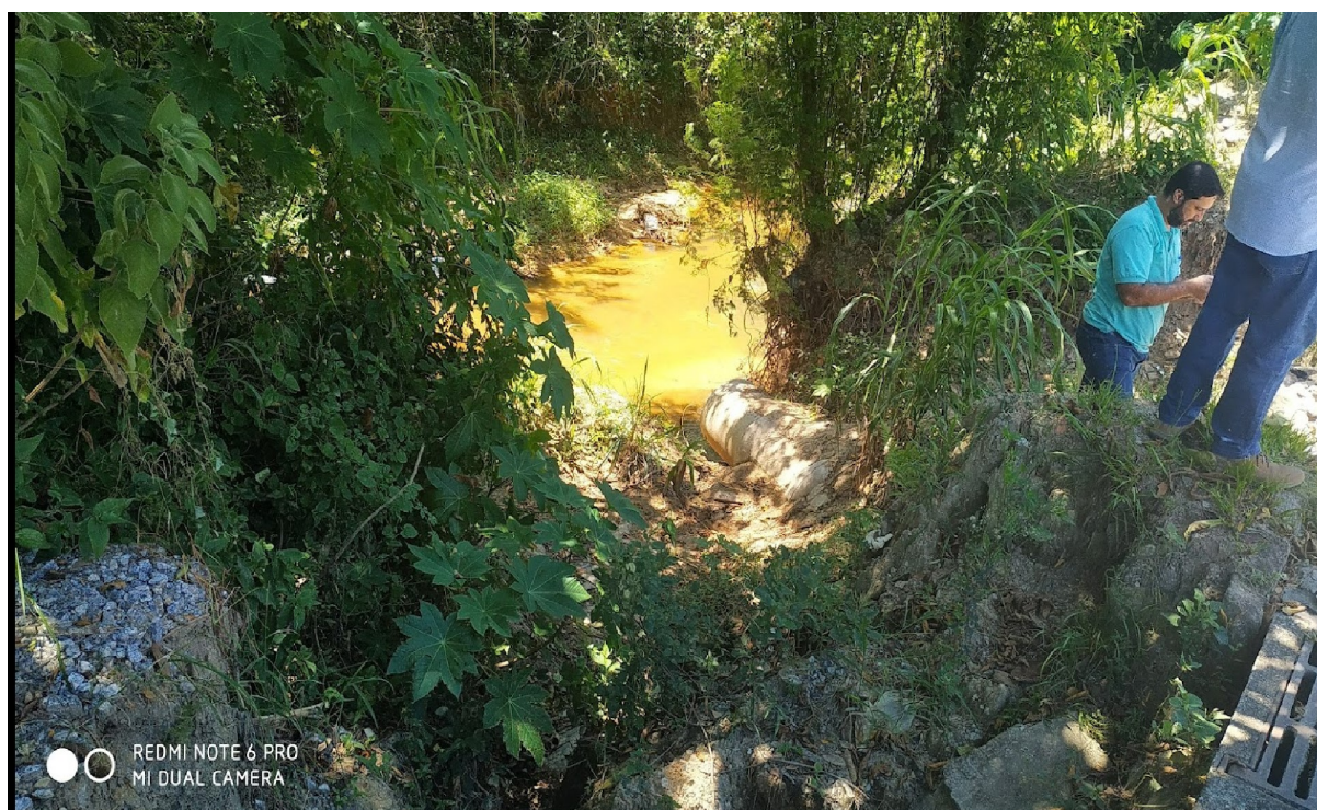
EROSÃO DAS MARGENS DO RIO INDAIAÇU, COM DANOS A REDE DE DRENAGEM E PAVIMENTO.
